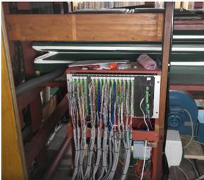
On entrevoit, derrière le nouveau boîtier électronique de gestion de l'orgue, le nouveau moteur et le soufflet réparé et repositionné à sa place.
